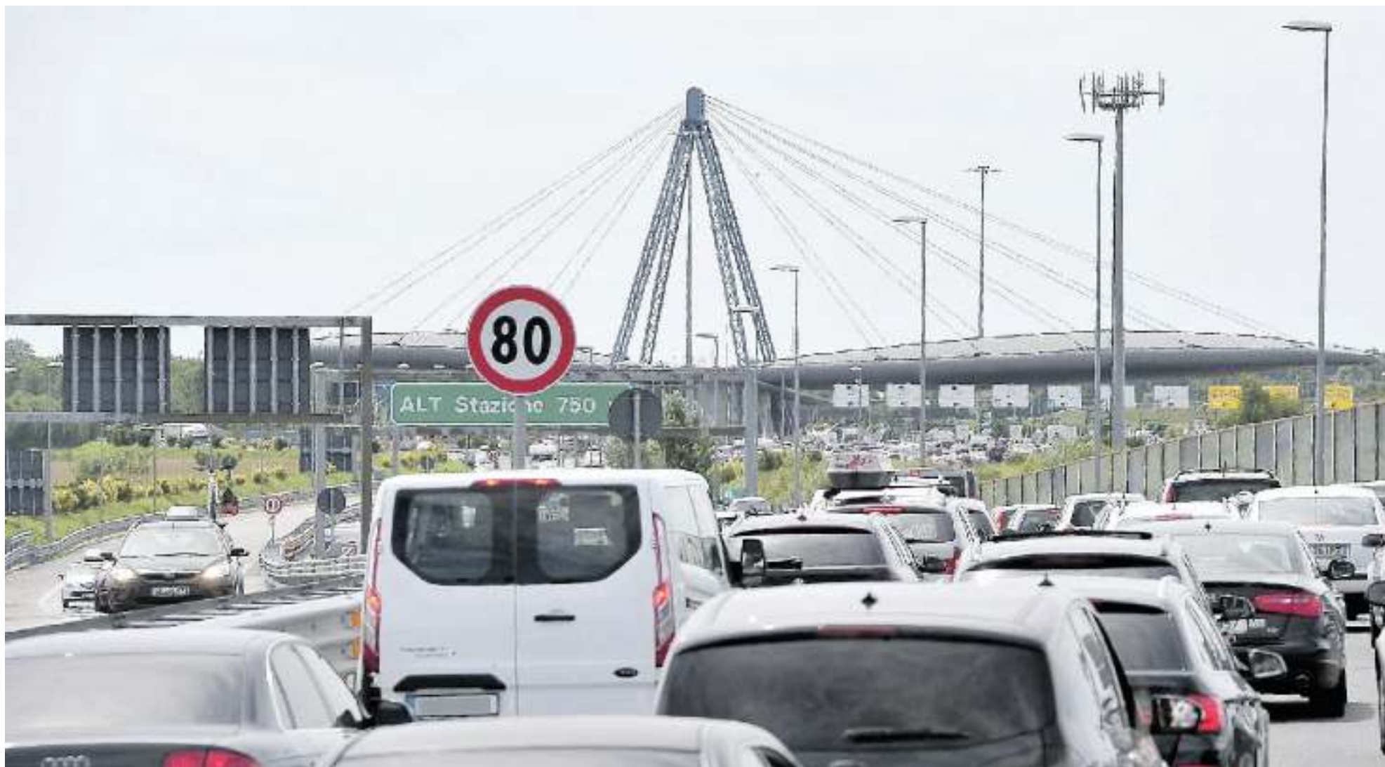
INQUINAMENTO ACUSTICO La società autostradale Autovie Venete ha stanziato 153 milioni di euro di qui al 2022 per ridurre l'impatto sonoro del traffico sulla sua rete
