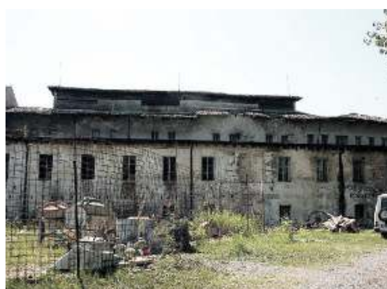
INTERVENTO Un'immagine d'archivio dello stabilimento dell'Amideria Chiozza di Ruda
