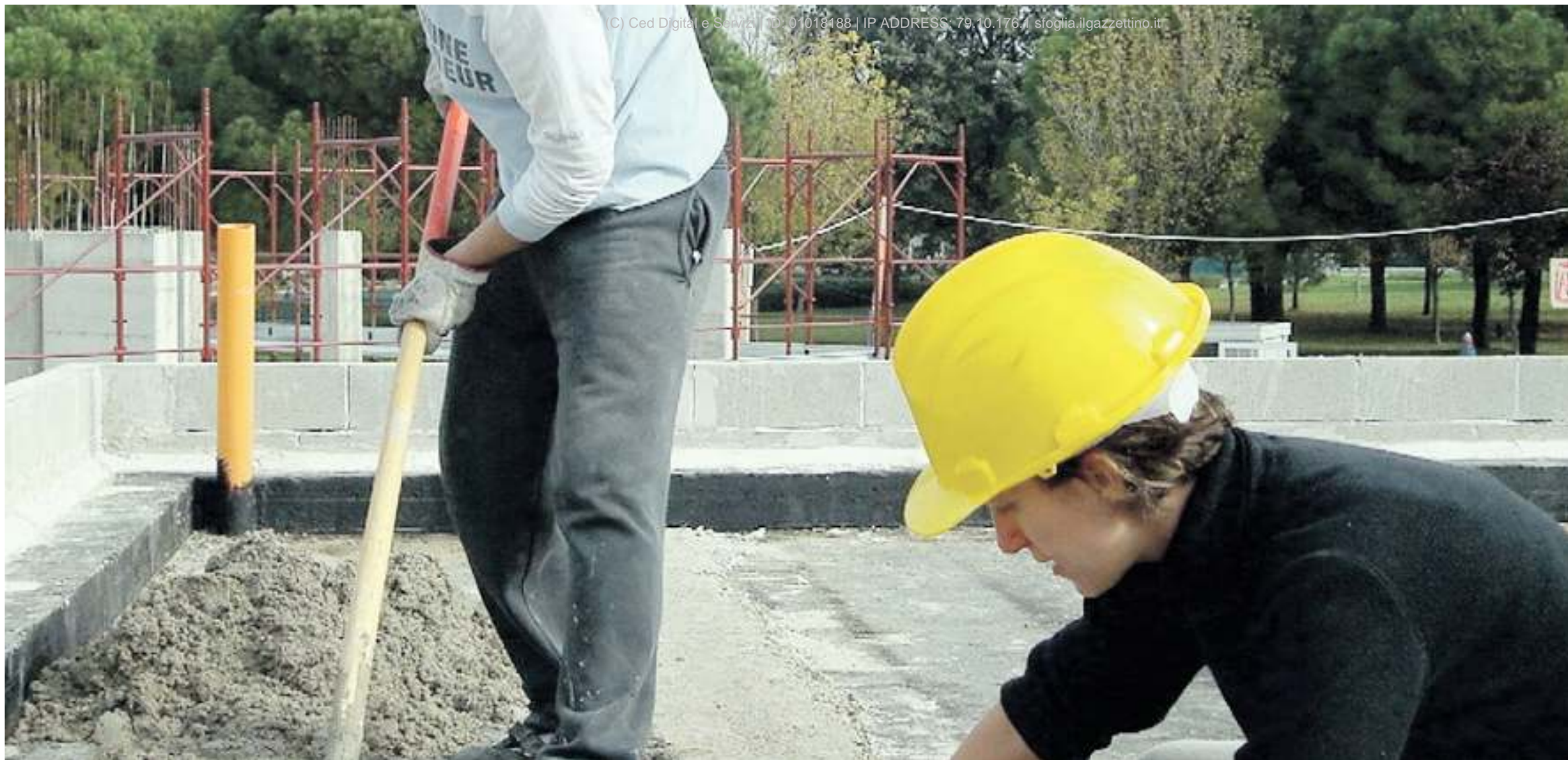
CANTIERE Operai al lavoro in un cantiere per la costruzione di un edificio, in una foto di repertorio
