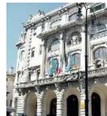
PALAZZO D'ARONCO La sede che ospita il Comune
