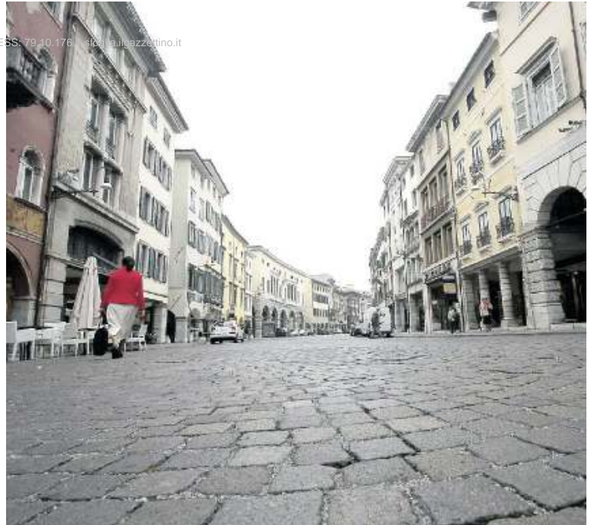
VIA MERCATOVECCHIO Questa mattina iniziano i lavori per le fognature e la ripavimentazione
